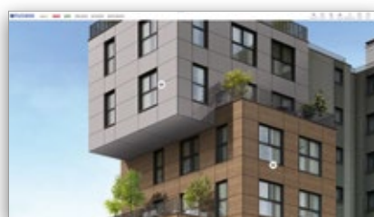
Vícepodlažní bytové domy
