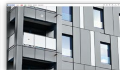
Balkóny a zábradlí
