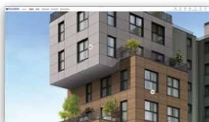
Vícepodlažní bytové domy
