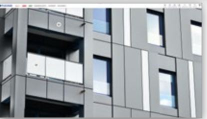
Balconi e balaustre
