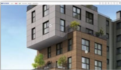
Immeuble à plusieurs étages
