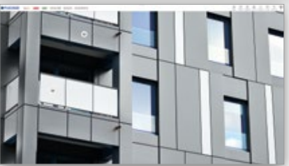
Balcons et parapets
