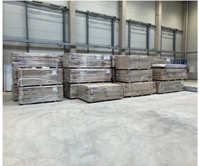
Abbildung 3: Korrekte Lagerung auf der Baustelle
