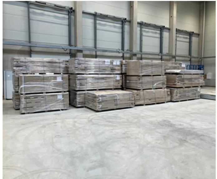
Abbildung 3: Korrekte Lagerung auf der Baustelle
